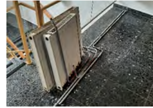
5: Die ausgetauschten Heizkörper
